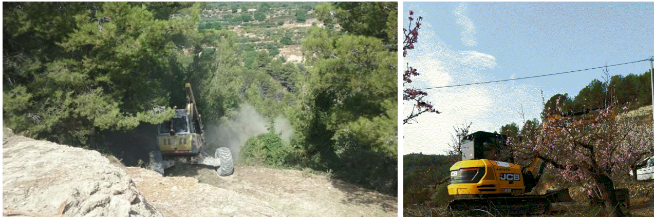
Detalle de la desbrozadora de martillos sobre retroexcavadora giratoria (derecha) y sobre retro-araña en terrenos escarpados (izquierda).
